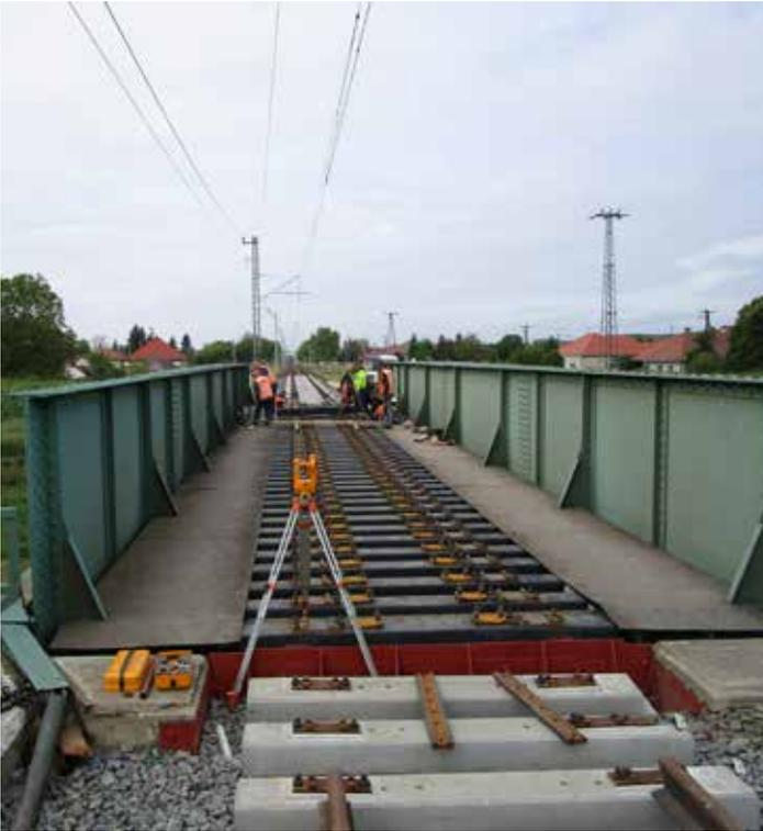
Image 2: Réglage / mise à niveau des traverses de pont.
