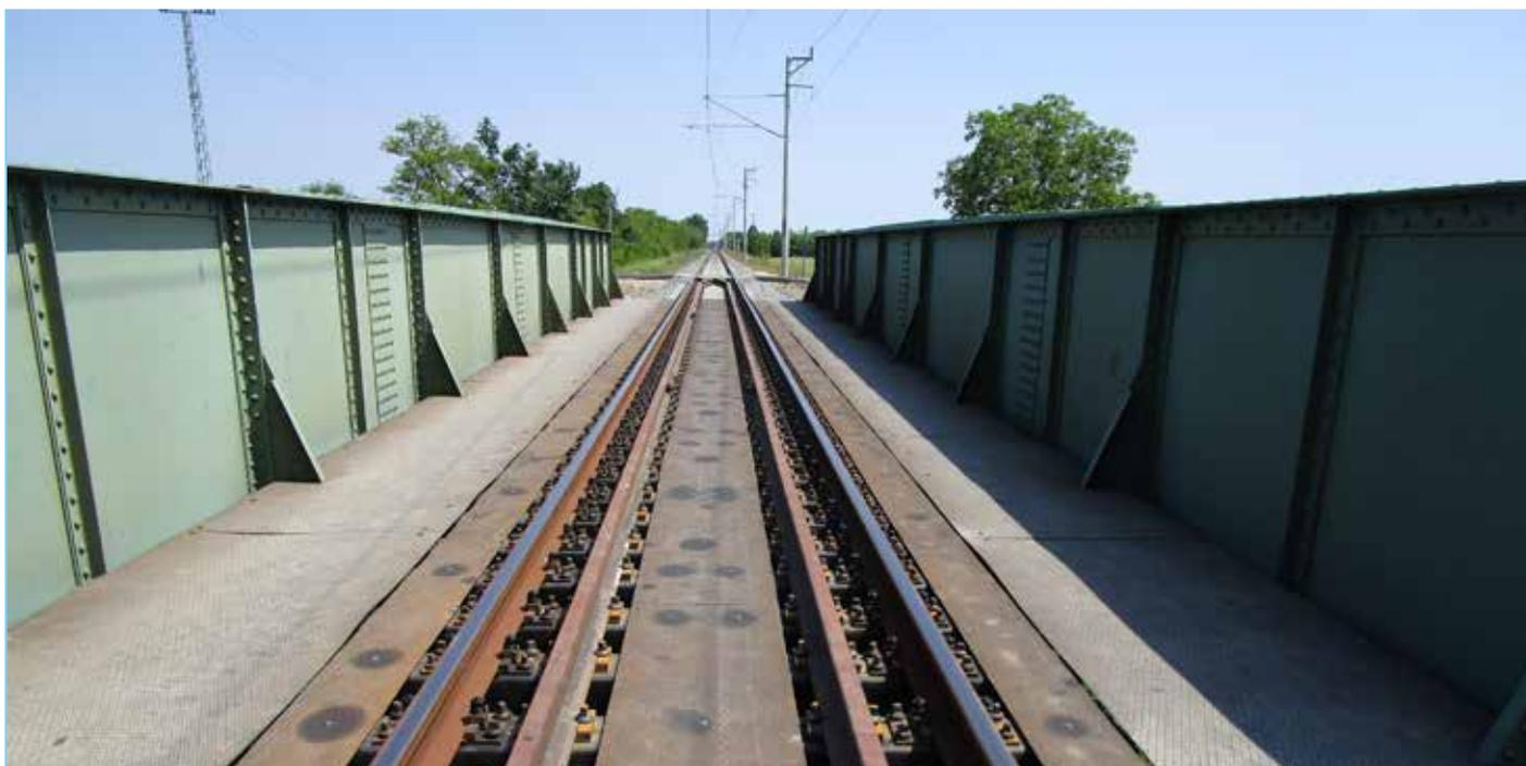
Image 1: Pont terminé avec des traverses composites **STRAILWAY**.
