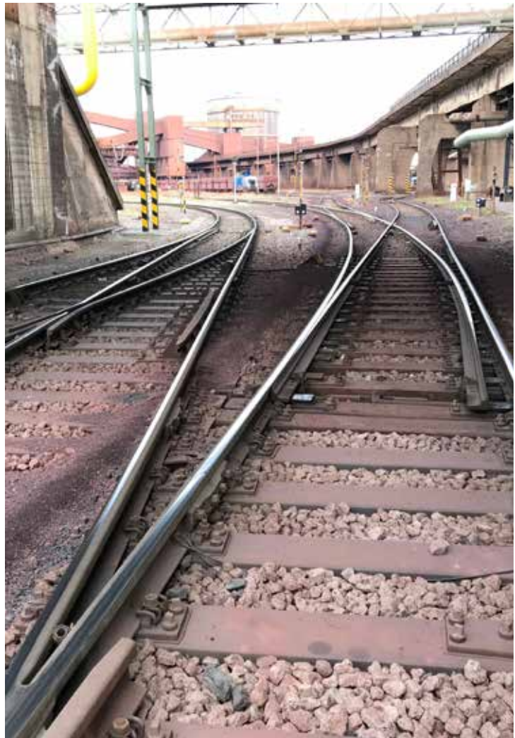
Image 5: aiguillage terminé pour charges lourdes avec les supports STRAILWAY .
