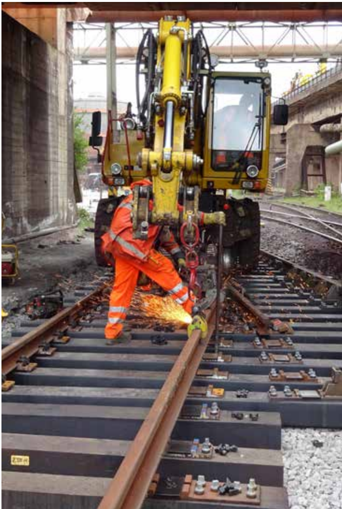
Image 4: Pose des supports STRAILWAY dans l'aiguillage de l'usine de l'aciérie de Salzgitter.
