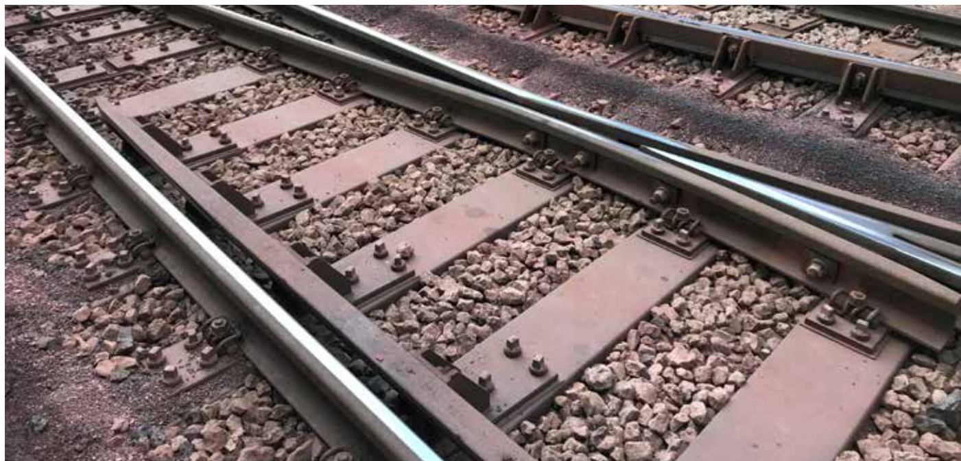
Image 1: Depuis 2018, les supports STRAILWAY de l'aciérie de Salzgitter résistent chaque année à une charge de env. 15 millions de tonnes brutes sans soucis.
