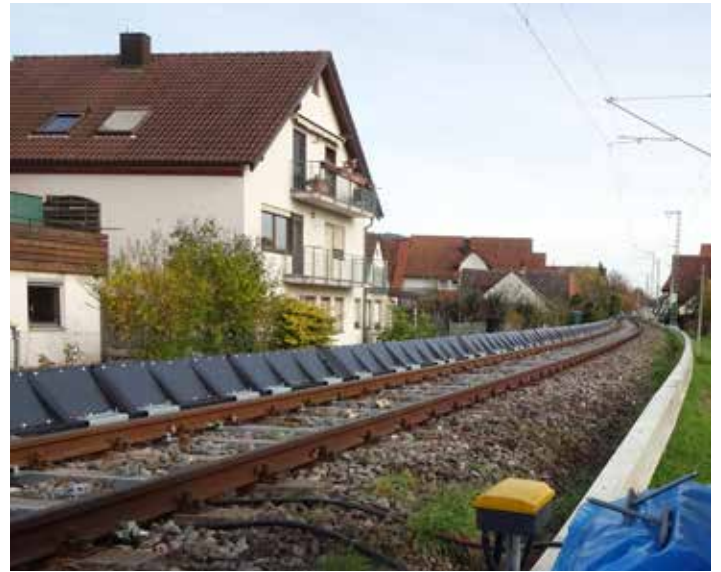
Image 3: Grâce à la faible hauteur du mSW 360 , la vue des riverains n'est pas gênée.
