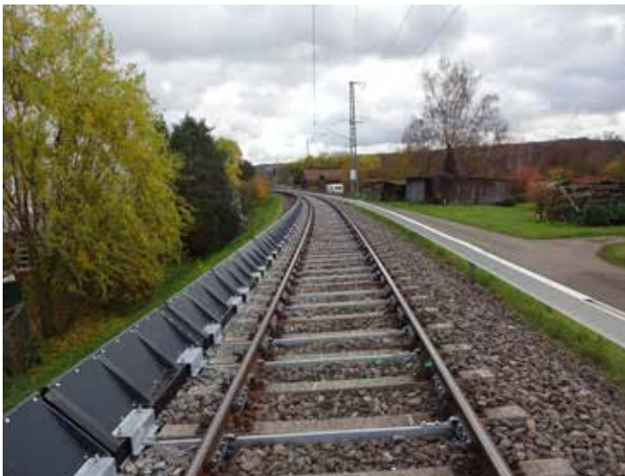
Image 4: Protection contre le bruit le long de la voie ferrée à Unterjesingen.
