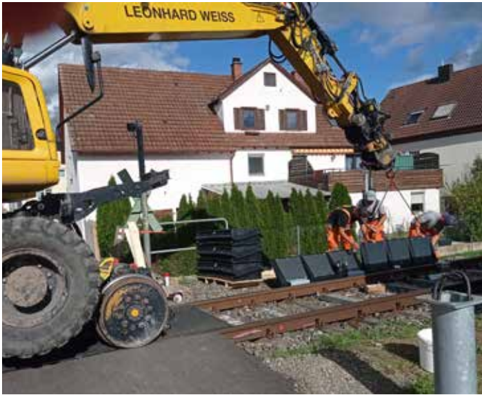
Image 2: Début de l'installation du mini-mur antibruit mSW 360 ..
