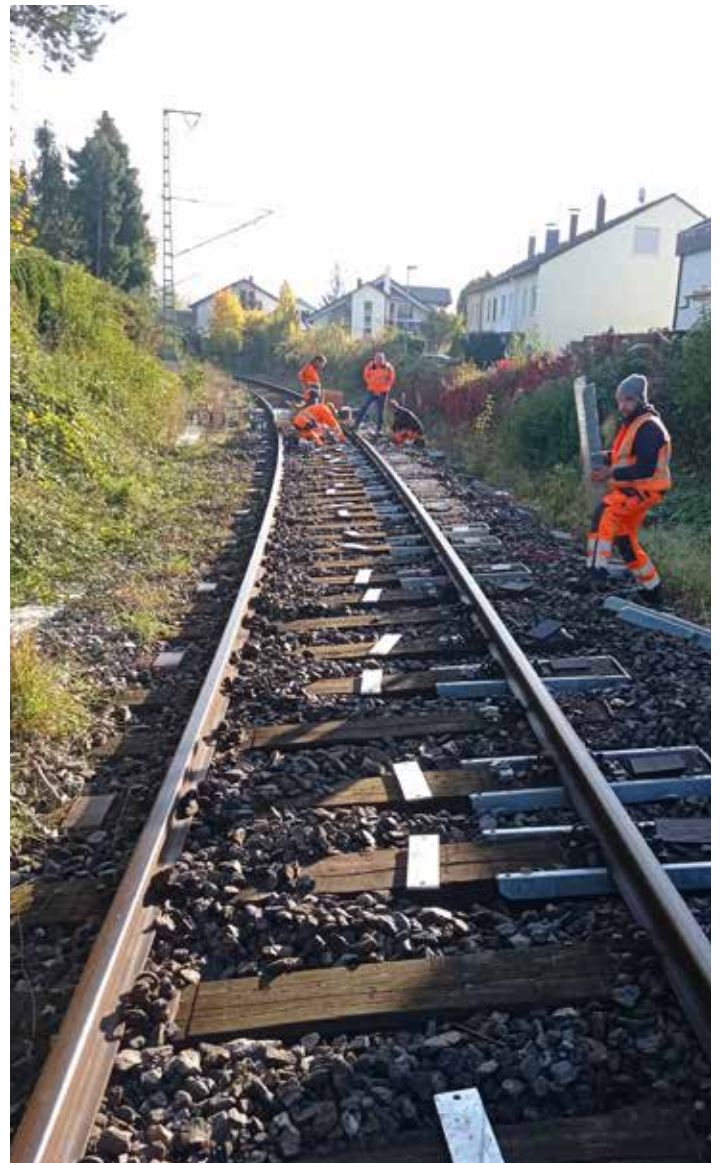
Image 6: Le châssis en acier est fixé directement au rail.
