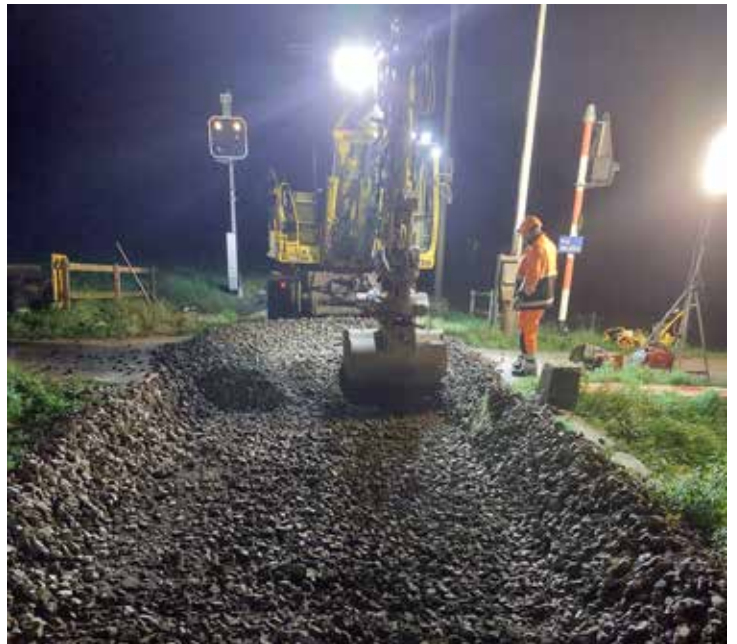
Image 3: Installation du ballast avec une excavatrice et un camion. Photo: Dominik Herrsche
