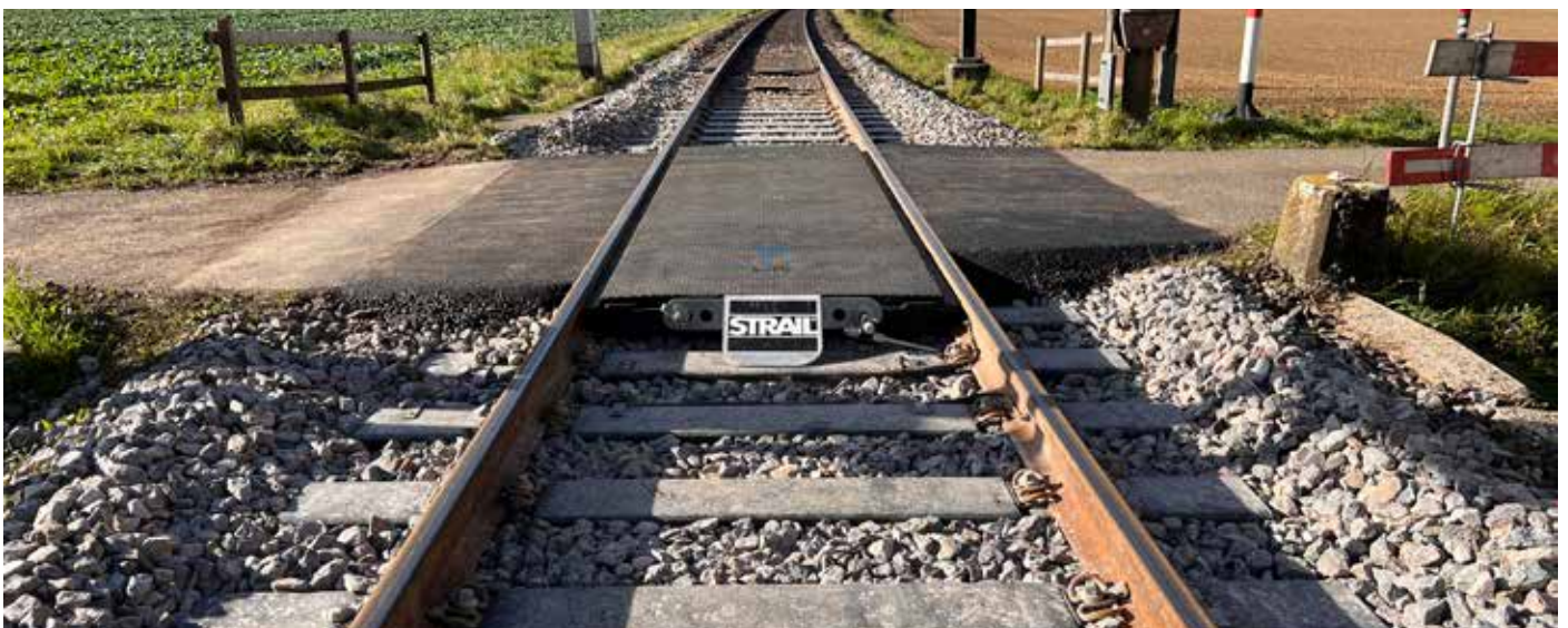
Image 1: Nouveau PN STRAIL avec traverses STRAILway dans la rue Sägenöschstraße. Photo: STRAIL
