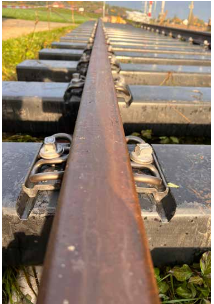
Image 5: Pour une pose était plus simple et plus rapide, la traverse STRALWAY , a été façonnée pour recevoir la fixation type W. Photo: STRAIL
