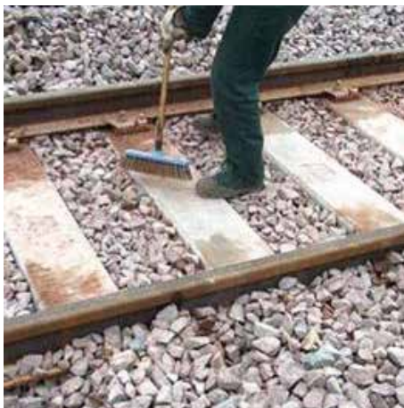
Balayage sur le dessus des traverses, attaches et rails.
