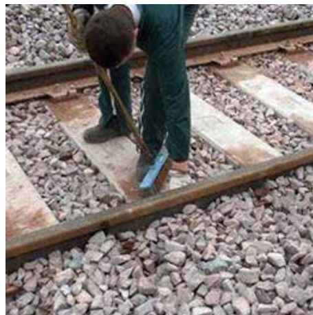
Balayage sur le dessus des traverses, attaches et rails.
