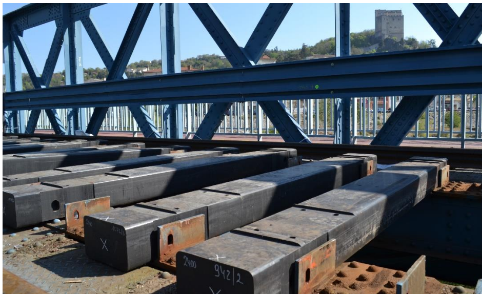
Figure 3 – Mise en place des STRAILway
