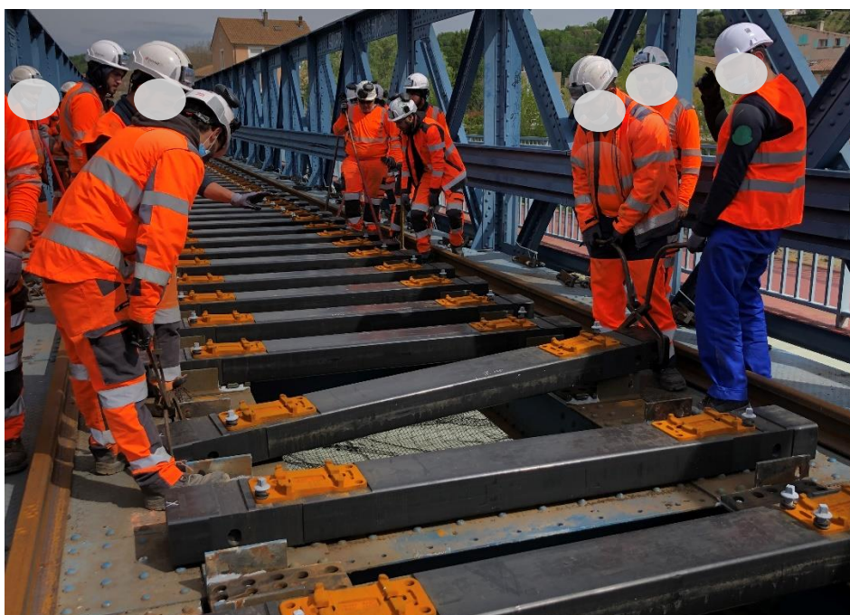
Figure 4 – Utilisation des pinces à traverse bois pour positionner les STRAILway
