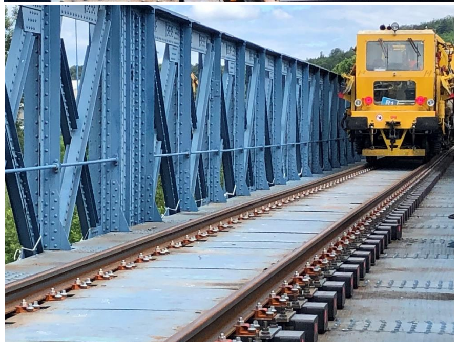
Figure 1 & 2 - Pont Bleu équipé des STRAILway
