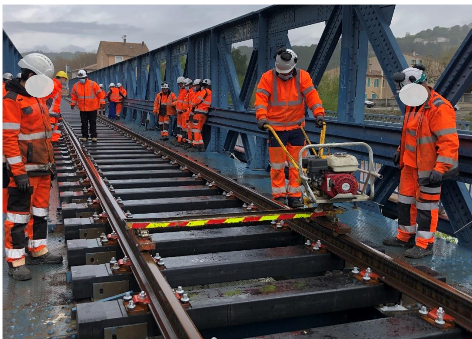
Figure 5 – serrage des attaches de rails avec un couple contrôlé
