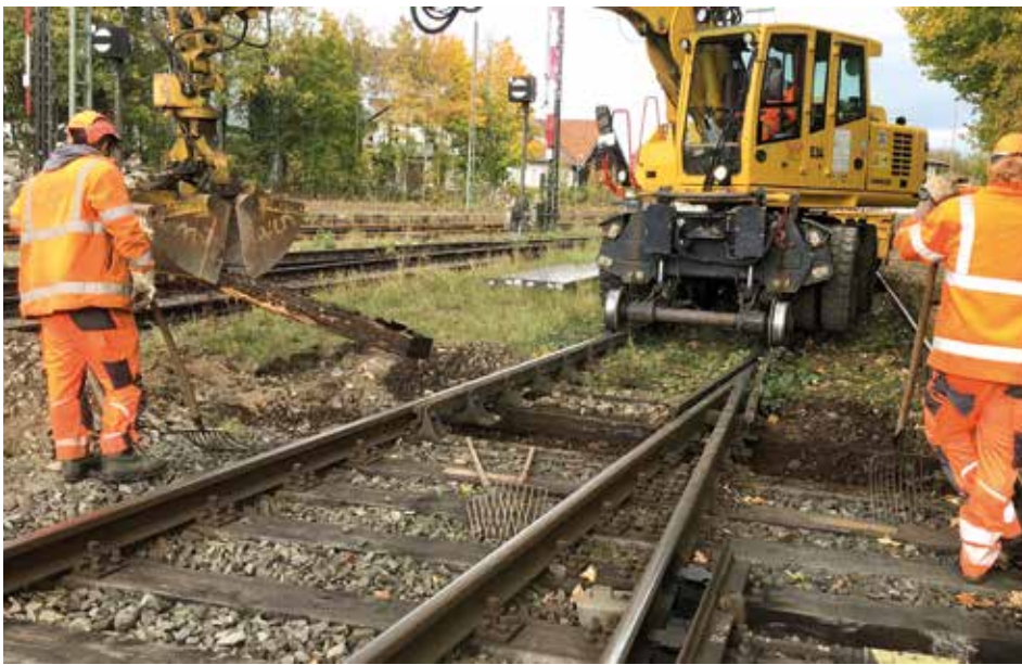
Figure 3 Démontage des anciennes traverses.
