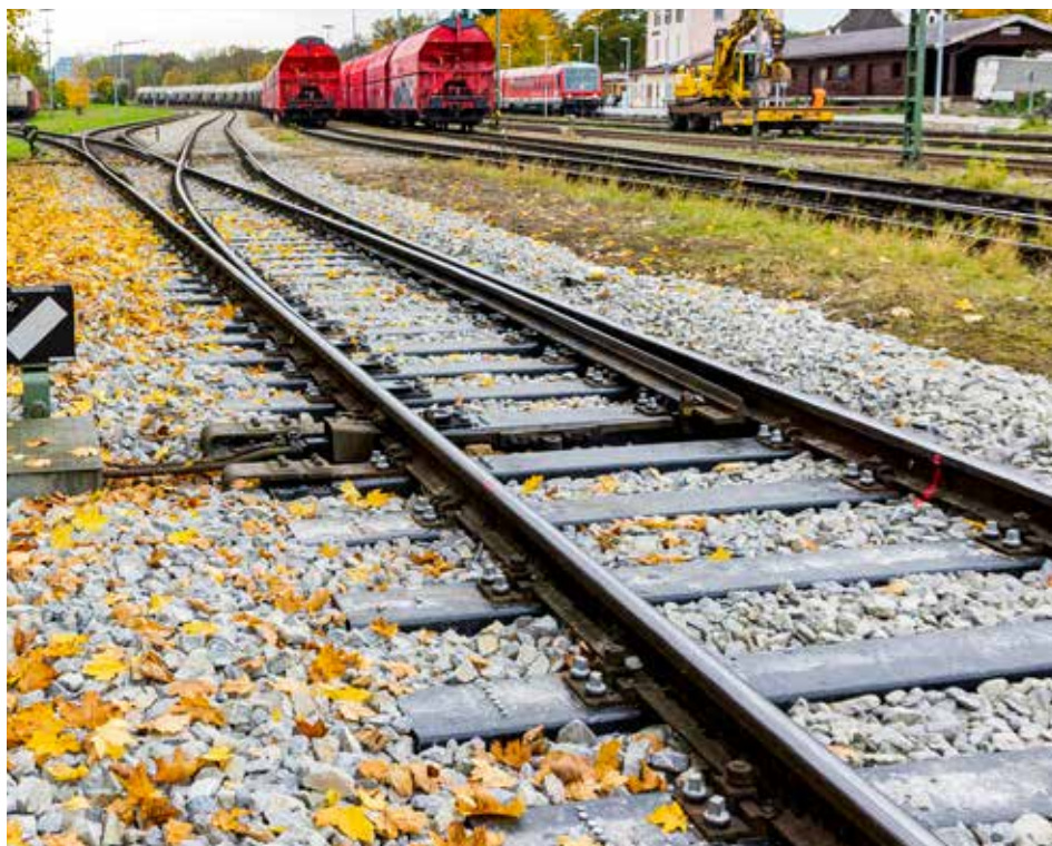
Figure 1 | Appareil terminé avec les traverses composites STRAILWAY .
