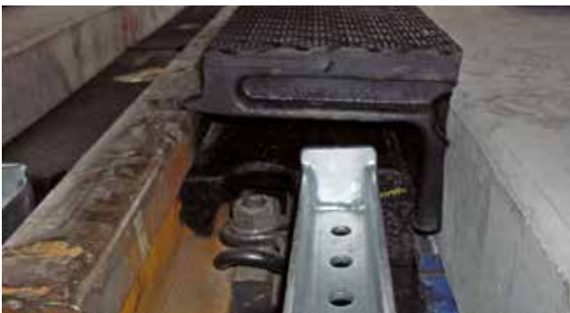
5) Mise en place des éléments extérieurs profilSTRAIL type c (sans ornière). Installer la première cornière d'extrémité. Si nécessaire graisser avec de la pâte de montage.
