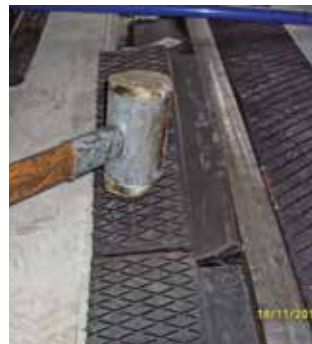
4) Ajuster les éléments profilSTRAIL type c avec un maillet. Si nécessaire utiliser notre outil de pose STRAIL/pédiSTRAIL .
