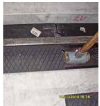
6) Ajuster les éléments extérieurs profilSTRAIL type c avec un maillet.
