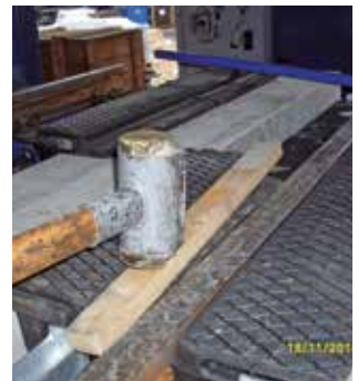
4) Ajuster les éléments profilSTRAIL type c avec un maillet. Si nécessaire utiliser notre outil de pose STRAIL/pédiSTRAIL .
