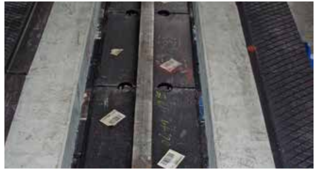
2) Installer les pièces compensatrices et les ajuster dans l'âme du rail.
