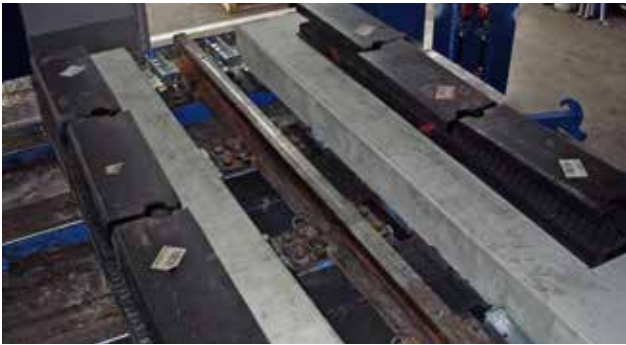
1) Préparation des pièces compensatrices et des profilSTRAIL type c intérieurs et extérieurs.
