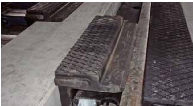
3) Mise en place des éléments intérieurs profilSTRAIL type c (avec ornière). Si nécessaire graisser avec de la pâte de montage.
