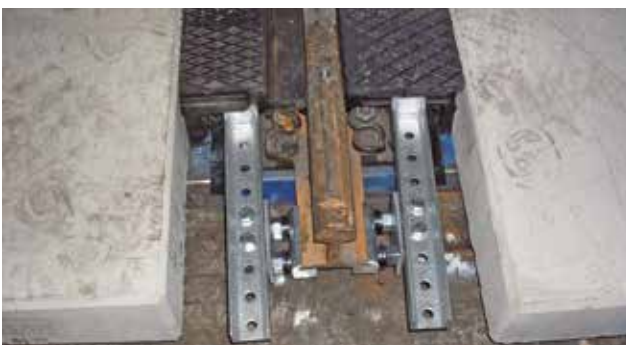
7) Ajuster et fixer les cornières d'extrémité.
