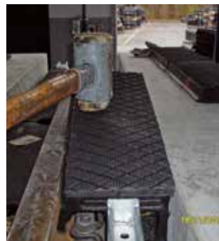
6) Ajuster les éléments extérieurs profilSTRAIL type c avec un maillet.
