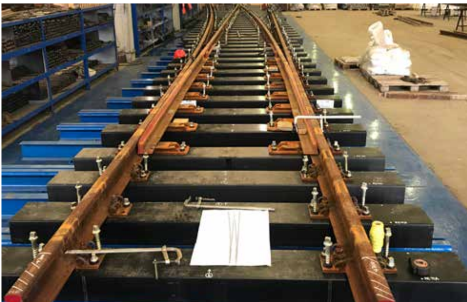
Figure 3 Pré-installation dans l'atelier.
