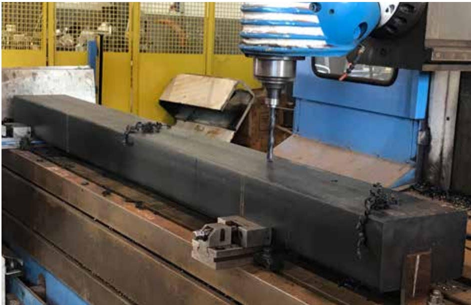
Figure 2 Perçage des trous à l'aide d'une machine CNC.
