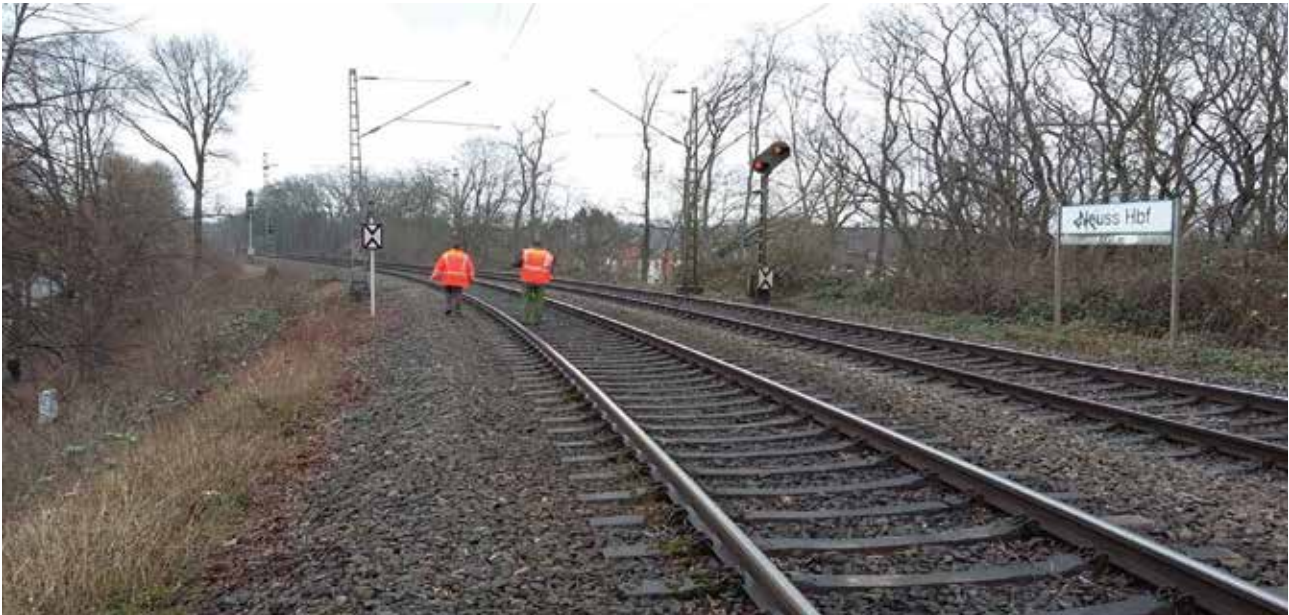
Image 2 – Embranchement du canal du Nord au signal à km 0,75
