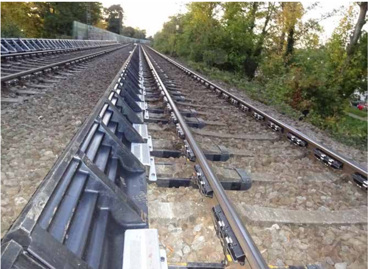
Image 9 – Installation STRAILastic_mSW et absorbeurs STRAILastic_A à Neuss.
