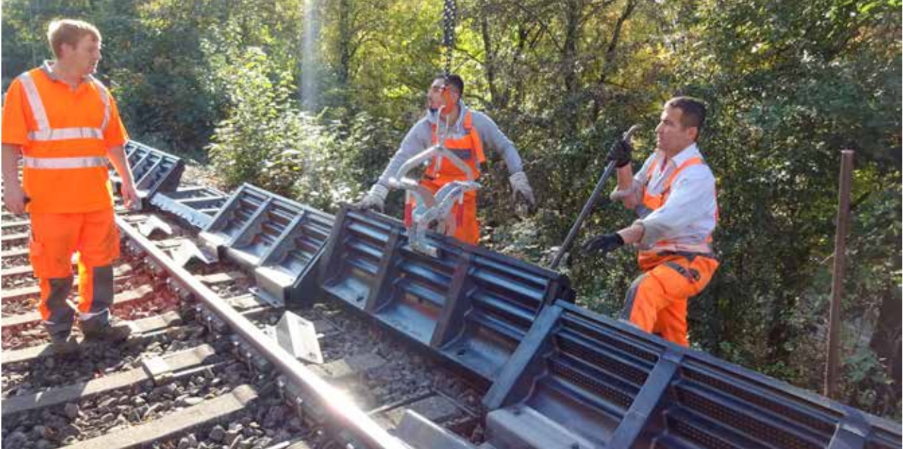
Image 7 – Installation des éléments en caoutchouc
