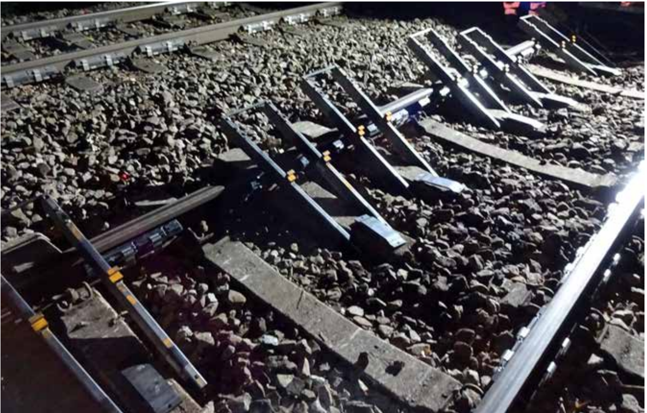
Image 5 – Pré-installation des supports aciers voie 2
