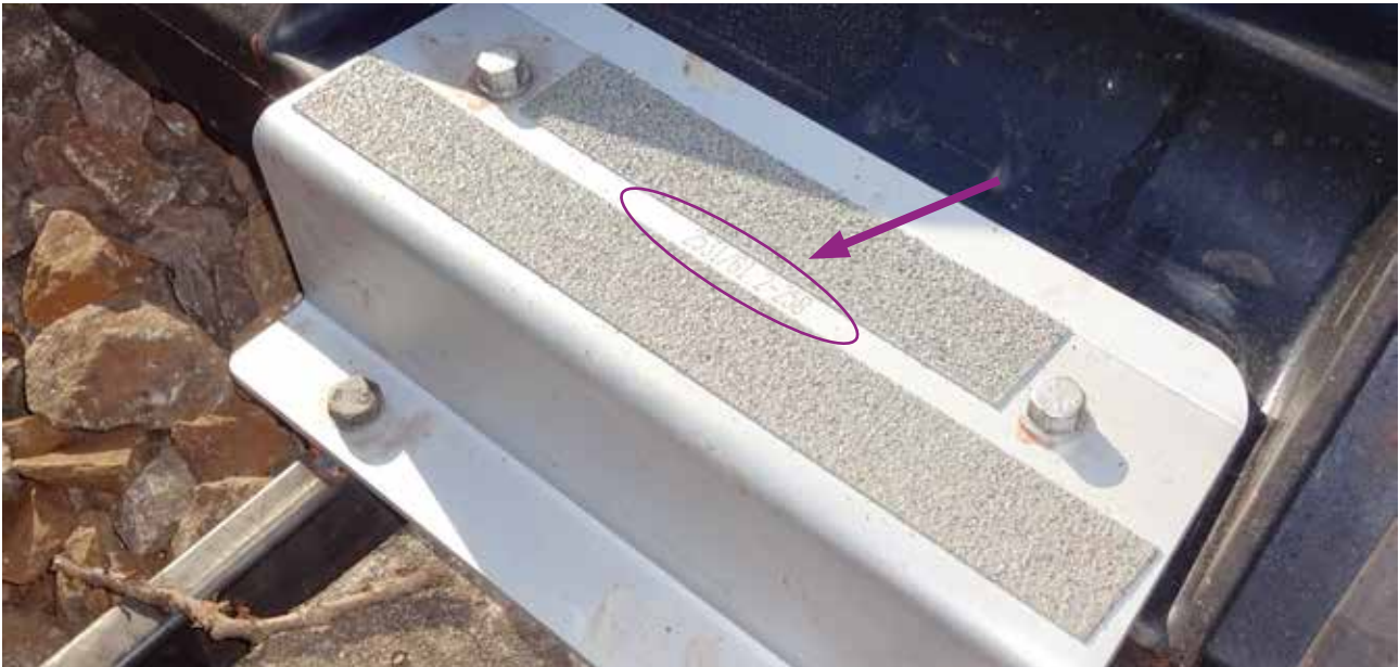
Image 10 – tôle Z de fixation spéciale (avec bande antidérapante)
