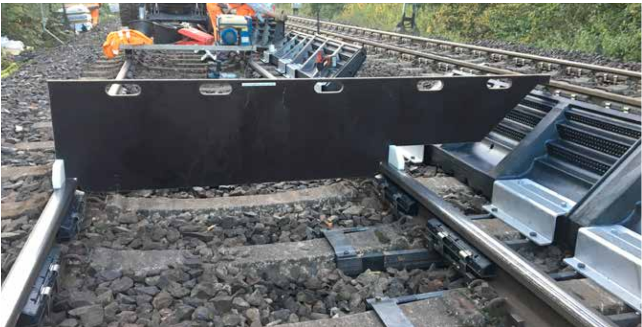
Image 8 – contrôle du gabarit ferroviaire
