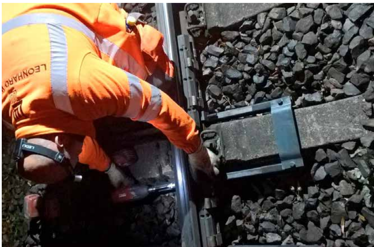
Image 4 - Installation des supports aciers voie 1
