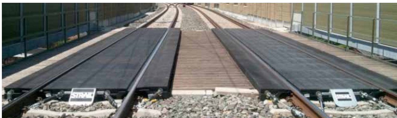
Le pont est installé avec STRAIL® et STRAILlastic_A
