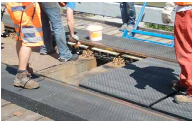
Installation des dalles intérieures
