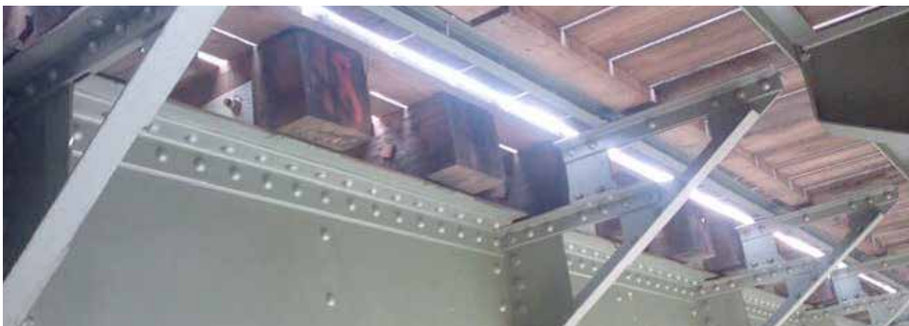
Structure du pont
