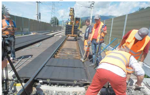
Installation des dalles intérieures
