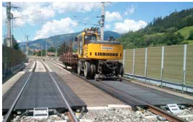
Transport des parties en bois et en acier
