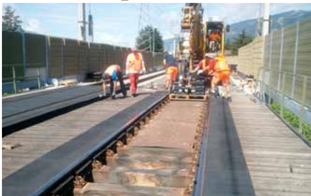
Installation des dalles extérieures
