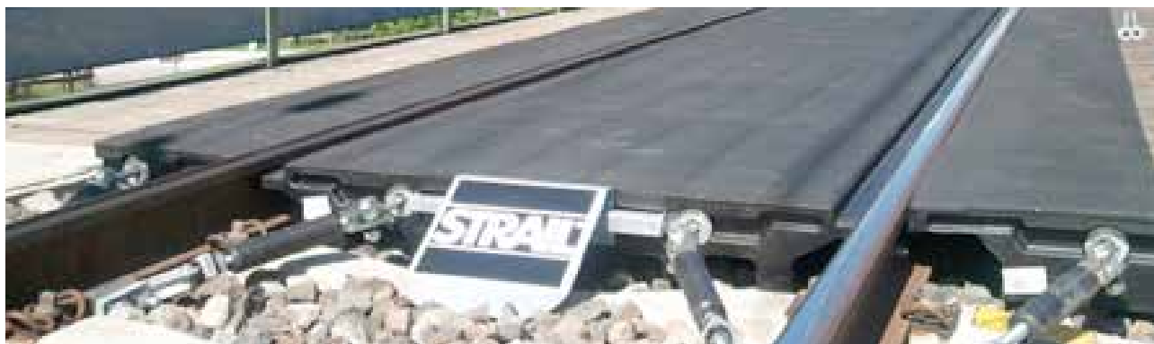
Le pont est installé avec STRAIL® et STRAILlastic_A
