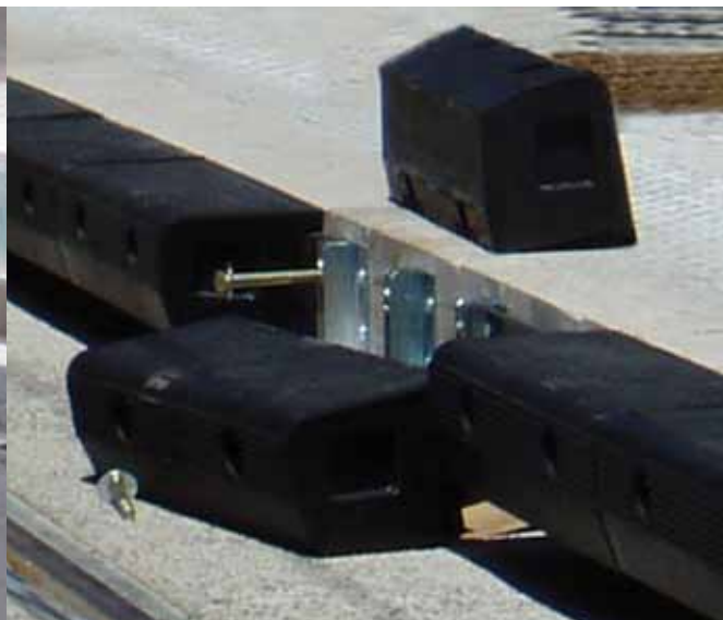
Pose des bordures en caoutchouc et fixation.
