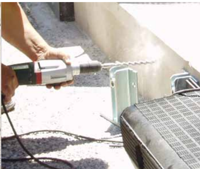
Afin d'assurer la fixation des équerres, perçage de la superstructure du quai.
