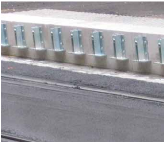
Fixation des équerres à intervalles réguliers de 400 mm.
