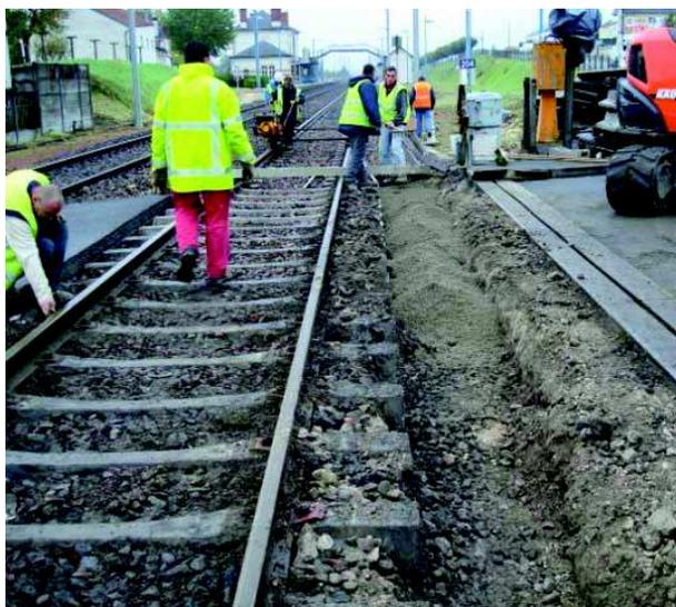
Après l'excavation, réalisation de la fondation béton (béton type BPS NF EN 206-1 XC1 C20/25 - impératif) sur une hauteur de 200 à 250 mm.
