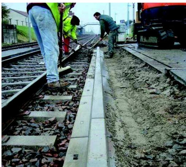
Comblers l'espace entre les traverses et les bordures avec du ballast.
