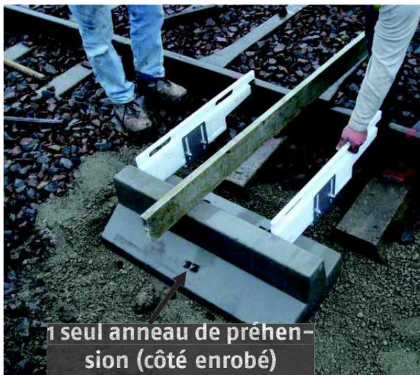
Disposer les bordures béton à l'aide d'élingues en les positionnant par rapport au rail avec les gabarits fournis épousant la forme de la bordure.
