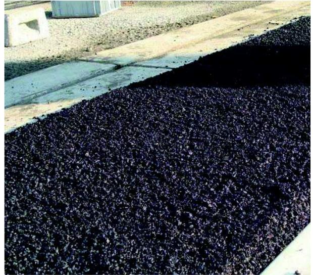
Mise en oeuvre de la 1<sup>ère</sup> couche d'enrobé à chaud de 40 mm, compactage, puis mise en oeuvre de la couche définitive.
