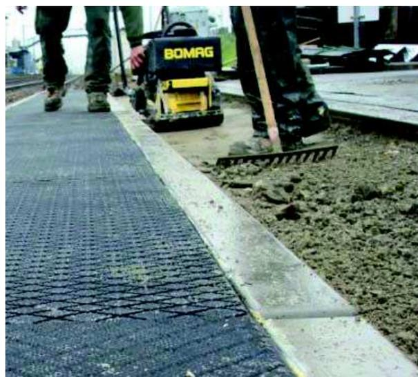
Compactage à la plaque vibrante de la couche de béton type BPS NF EN 206-1 XC1 C20/25 jusqu'à - 8 cm par rapport au niveau de la chaussée.
