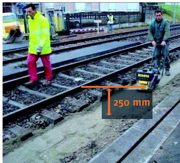
Réaliser un compactage du béton de façon à obtenir une surface homogène et plane et une hauteur constante de 250 mm par rapport au niveau supérieur du champignon du rail.
